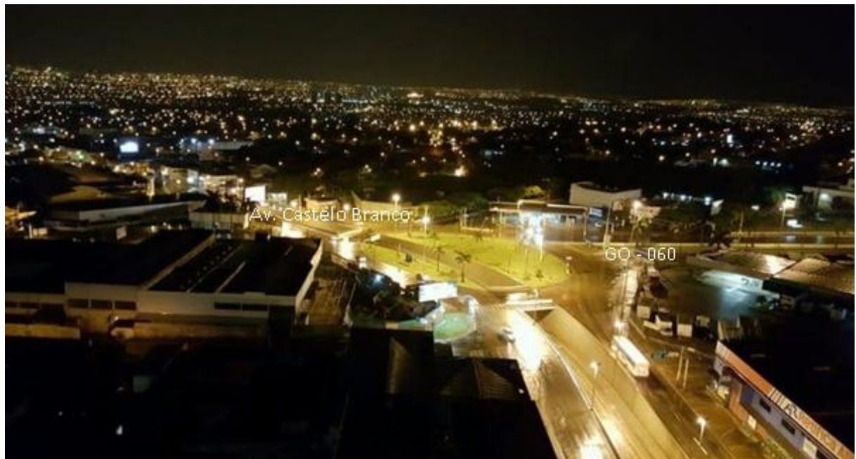
Figura 2 – Imagem aérea do Viaduto Leôncio Barbosa da Silveira - cruzamento das vias Av. Anhanguera, Av. Castelo Branco e GO-060.
