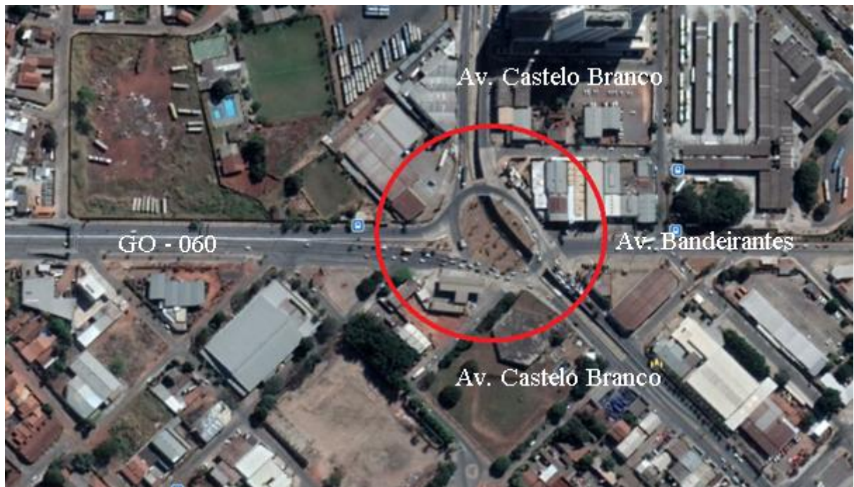
Figura 6 – Geometria do Viaduto Leônicio Barbosa da Silveira. Fonte: Google Earth , 2018.
