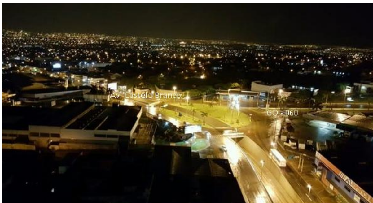
Figura 2 – Imagem aérea do Viaduto Leônicio Barbosa da Silveira - cruzamento das vias Av. Anhanguera, Av. Castelo Branco e GO-060. Fonte: Foursquare, 2019.
