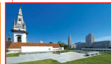
Figura 19: Telhado Verde na laje Fonte: Brando, 2014
