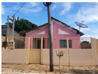
Figura 72: Edificação Térrea Fonte: Ribeiro, 2019.
