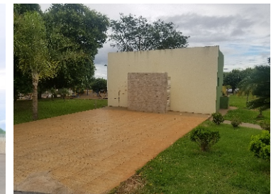
Figura 10: Bateria de Sanitários Fonte: Ribeiro, 2019.
