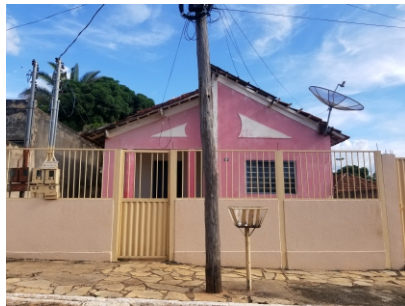
Figura 72: Edificação Térrea Fonte: Ribeiro, 2019.
