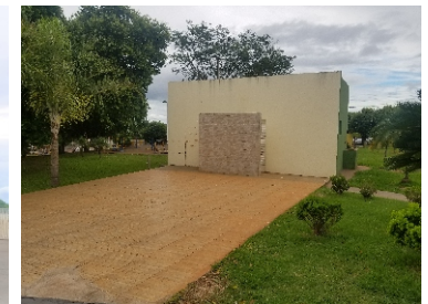
Figura 10: Bateria de Sanitários Fonte: Ribeiro, 2019.
