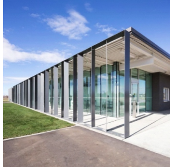
Figura 27: Pavilhão do Parque Esportivo Mill Woods Fonte: http://www.dubarchitects
