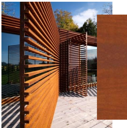
Figura 84: Brise em aço corten.
