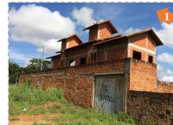
Figura 51: Edificação de 2 pavimentos.
