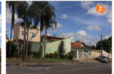
Figura 52: Edificação de 2 pavimentos.
