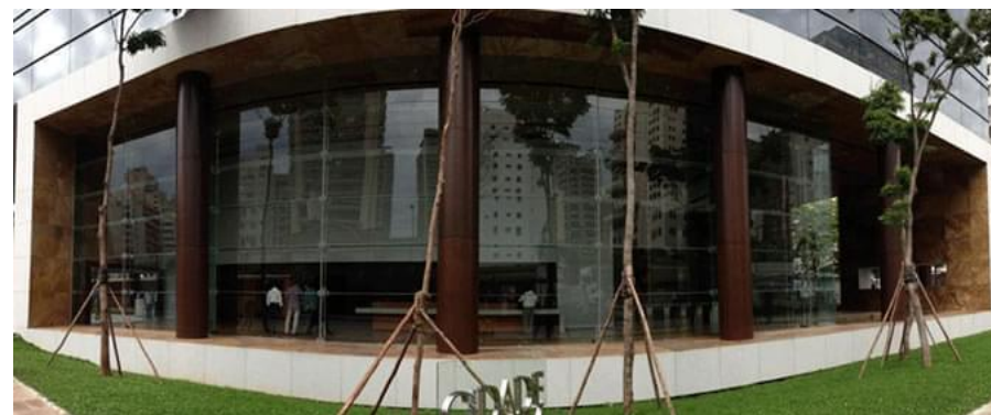
Figura 47: Fachada com vidro estrutural. Fonte: AECweb, 2020.
