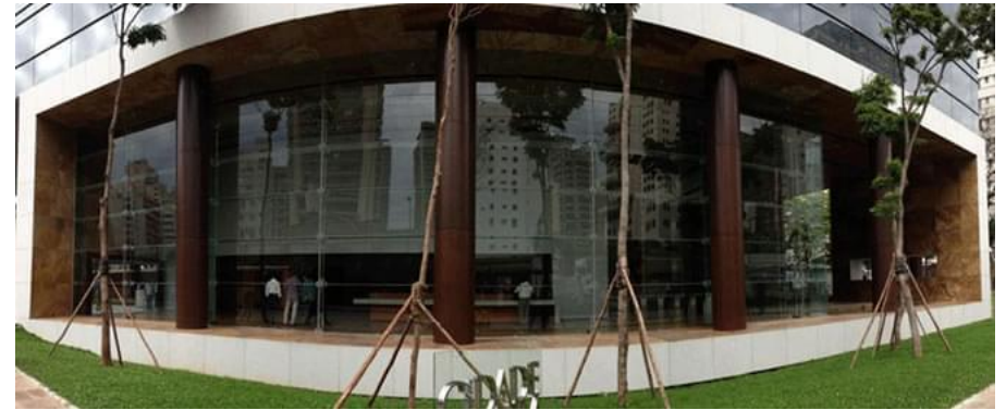
Figura 47: Fachada com vidro estrutural. Fonte: AECweb, 2020.
