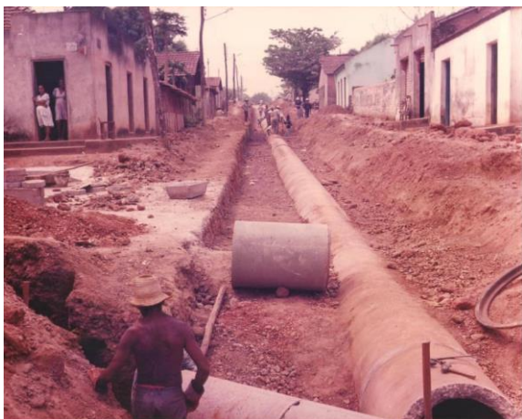
Figura 14: Instalação de manilhas - Esgoto, 1981. Fonte: João Pedro Milhomem.
