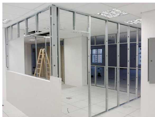
Figura 76: Parede em Gesso Acartonado. Fonte: blogdogesseiro.com.br
