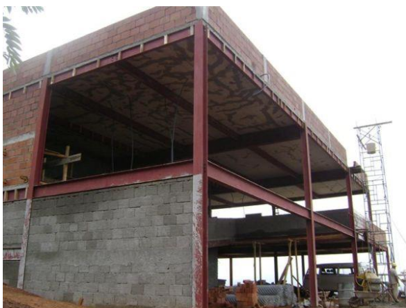
Figura 76: Estrutura Metálica Fonte: oitoemeia.com.br
