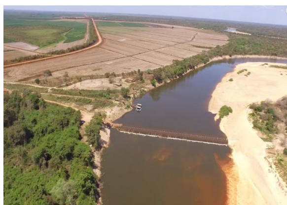
Figura 13: Bombas no Rio Formoso. Fonte: onaengenharia.com.br
