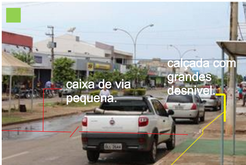
Figura 35: Detalhe caixa da via e calçadas. Fonte: Arquivo pessoal.
