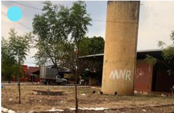
Figura 58: Poço com tampa quebrada Fonte: Arquivo pessoal.
