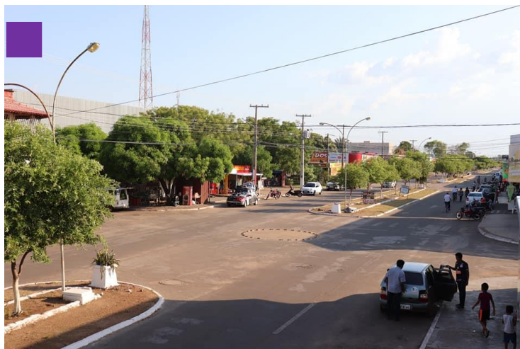
Figura 36: Ausência de sinalização na via Fonte: Arquivo pessoal.
