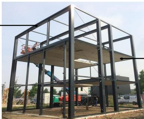
Figura 84 : Sistema estrutural metálico
