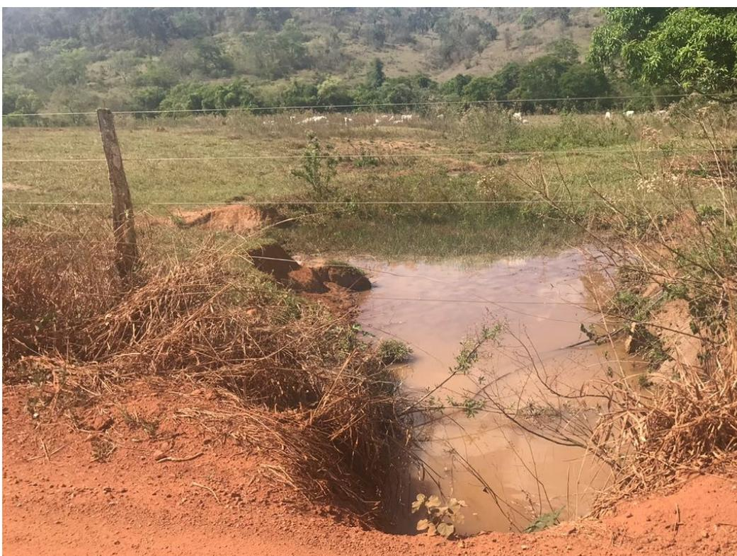
Figura 12 - Descarga de drenagem de água pluvial, estrada Santa Tereza.
