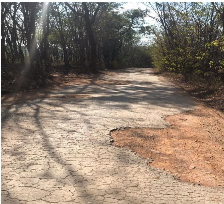
Figura 10: Degradação do material presente na estrada e buracos.
