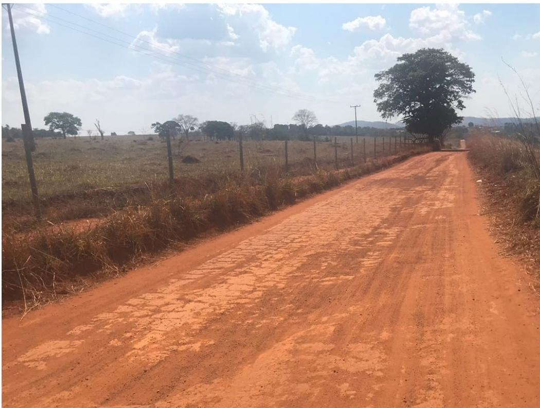
Figura 13 – Seção transversal inadequada, estrada Santa Tereza.
