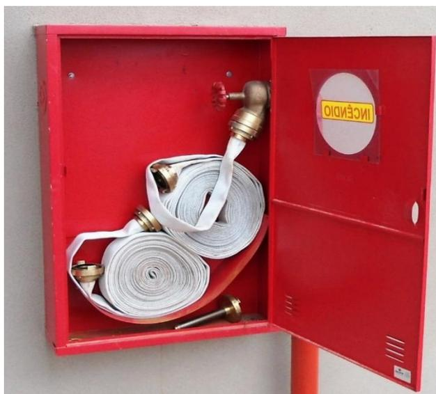
Figura 2: Abrigo com hidrante.
