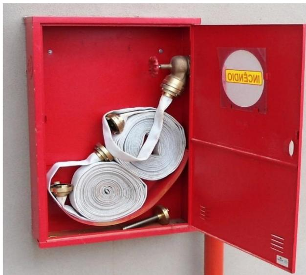
Figura 2: Abrigo com hidrante.
