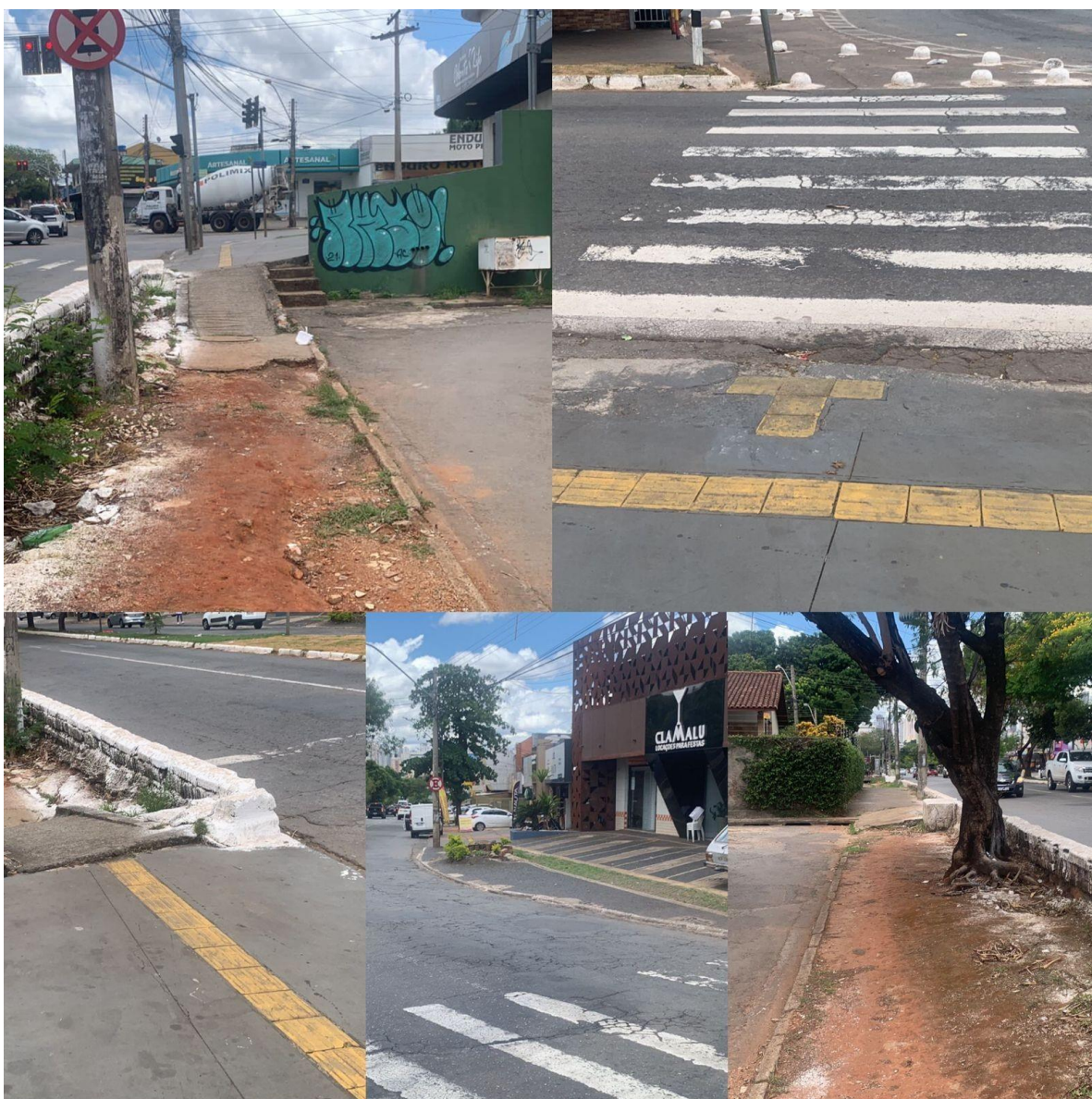
Figura 7- Acessibilidade e Mobilidade no calçamento da Av. T-9, Vila União, Goiânia. Fonte: Autores, 2022.
