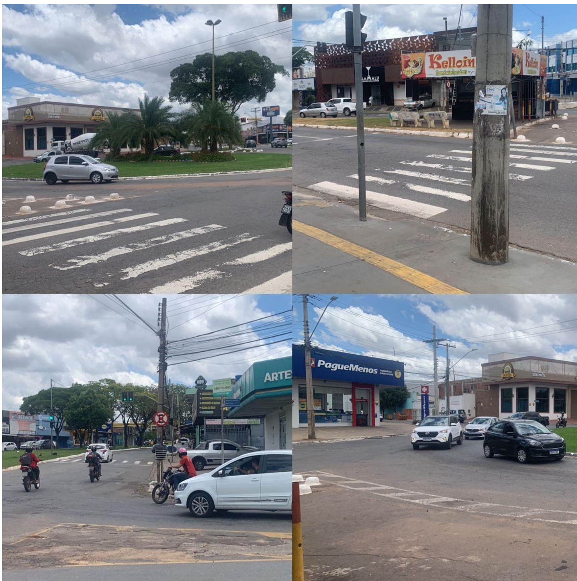
Figura 8 - Sinalizações verticais e horizontais na Av. T-9 e Rua U-82, Vila União, Goiânia. Fonte: Autores, 2022.
