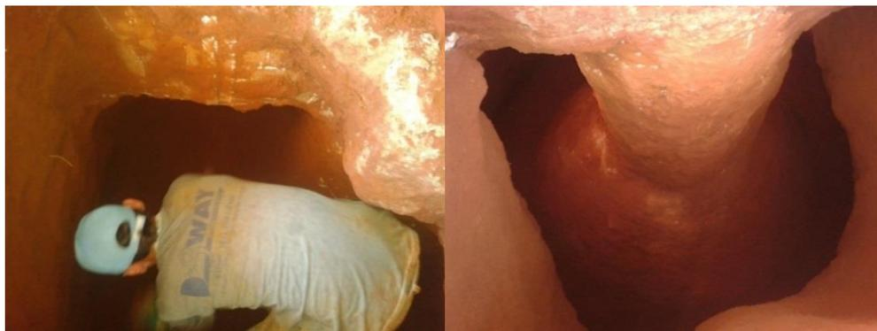
Figura 2 e 3 – Detalhe do tubulão escavado
