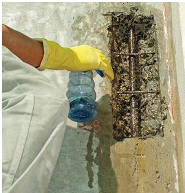
Figura 8 – Saturação do Concreto
