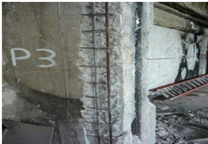
Figura 5 – Escarificação do pilar
