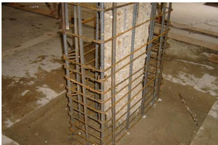
Figura 10 – Pilar pronto para concretagem
