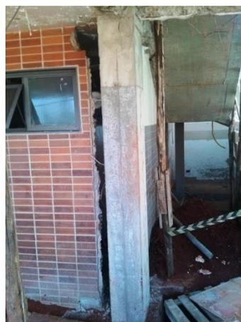
Figura 11 – Pilar “A” Reforçado na Forma    Figura 12 – Pilar “B” Reforçado Concretado
