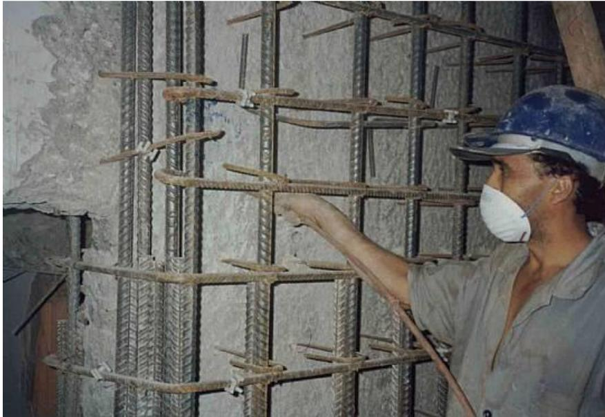
Figura 7 – Limpeza da superfície com ar comprimido
