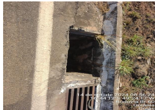
Figura 17 e 18. Ponto 09, Sistema de drenagem aberto, falta de manutenção.
