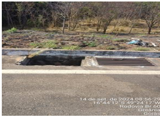
Figura 17 e 18. Ponto 09, Sistema de drenagem aberto, falta de manutenção.
