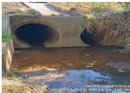
Figuras 3 e 4. Ponto 01, Boca de lobo sem manutenção.
