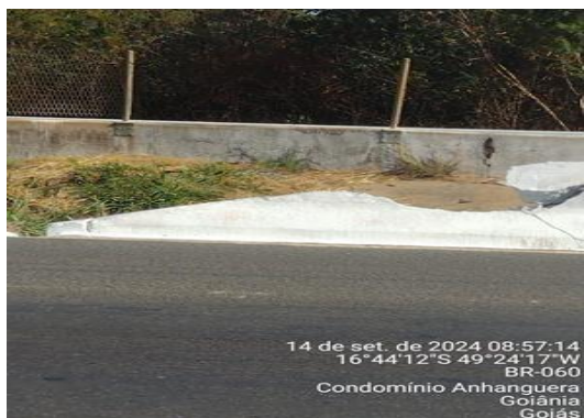
Figuras 19 e 20. Ponto 10, Mureta de proteção quebrada.
