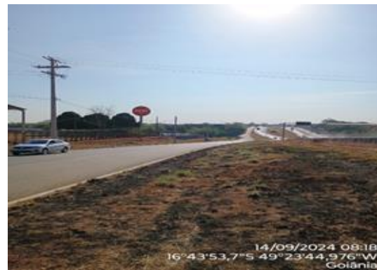
Ponto 04, Queimadas canteiro central da Go.
