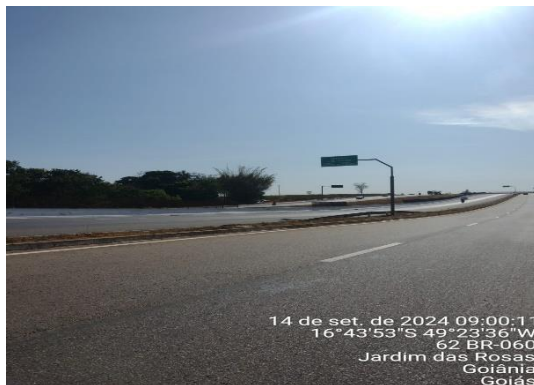
Figuras 7 e 8. Ponto 03, sem acostamento para parada de emergência.
