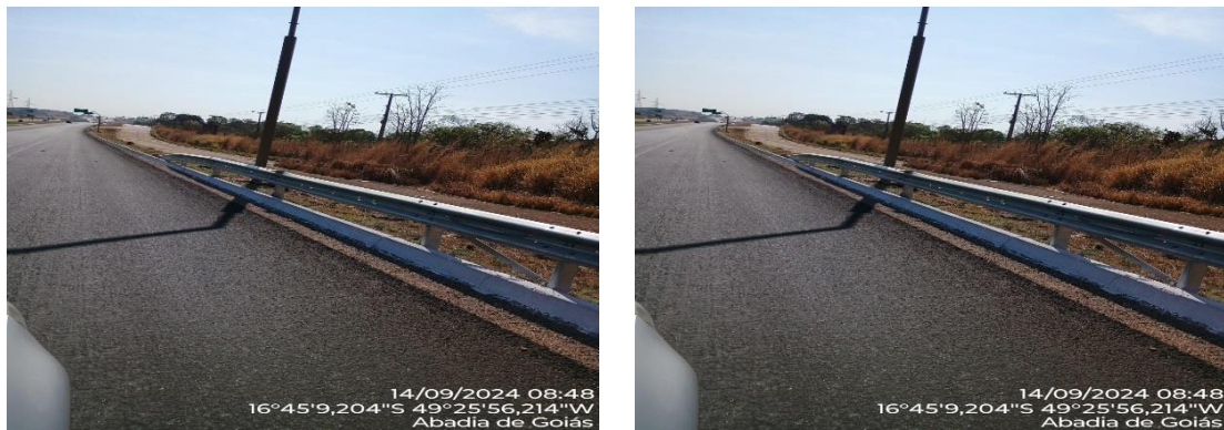
Figuras 25 e 26. Ponto 15, sem acostamento para parada de emergência.
