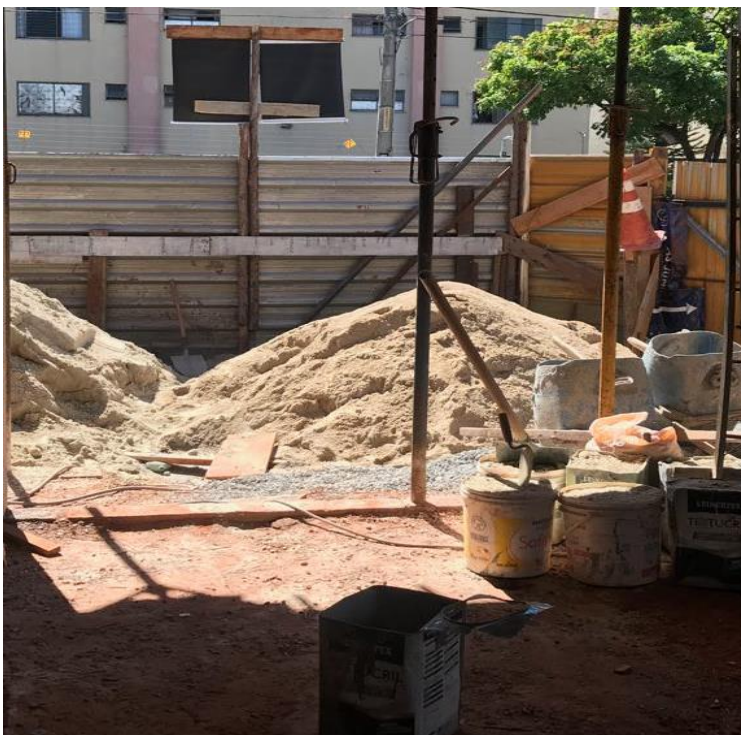
Figura 9. Disposição de areia e brita Fonte: Autor (2018).
