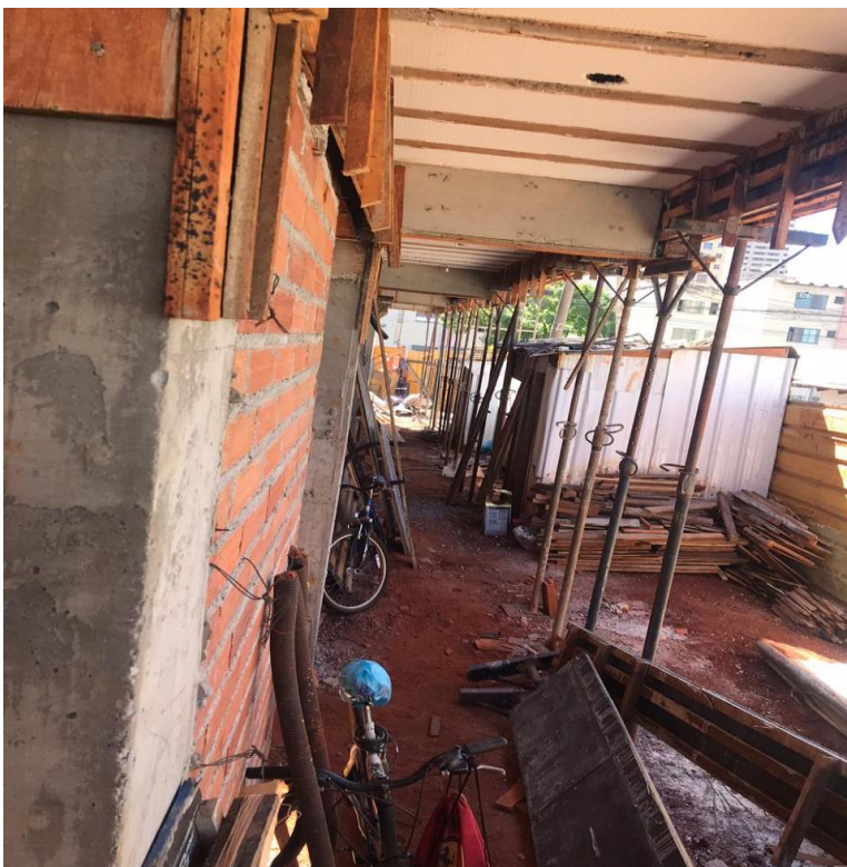
Figura 5. Local do canteiro inicial Fonte: Autor (2018).
