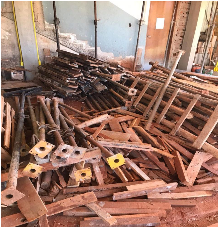
Figura 6. Abaixo da primeira laje Fonte: Autor (2018).
