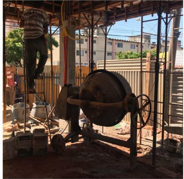
Figura 10. Elevação onde está a betoneira Figura 11. Betoneira vista por outro ângulo Fonte: Autor (2018).
