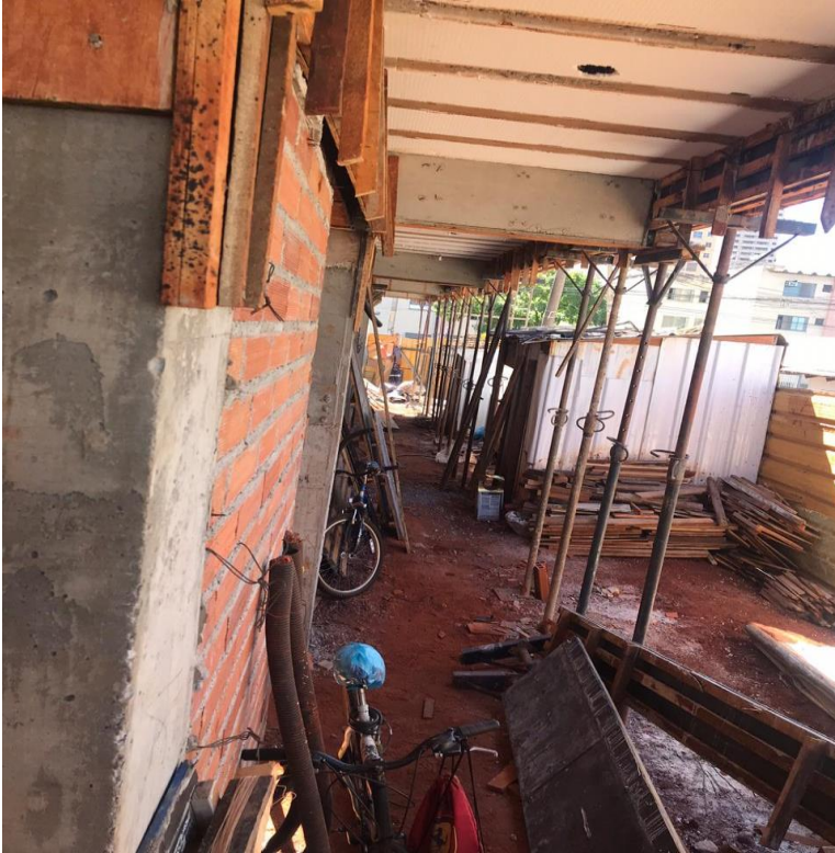
Figura 5. Local do canteiro inicial Fonte: Autor (2018).
