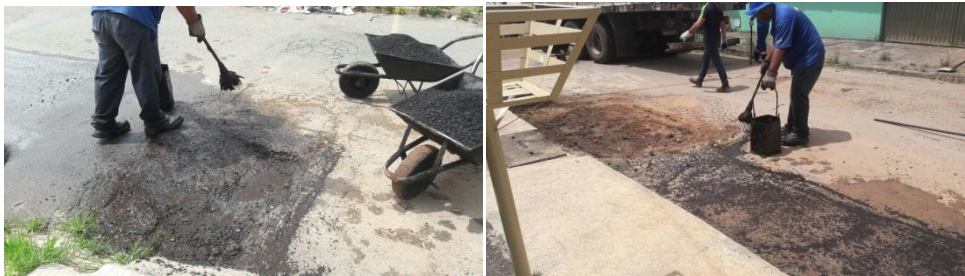
Figura 4. A e B - Aplicação do ligante asfáltico.
