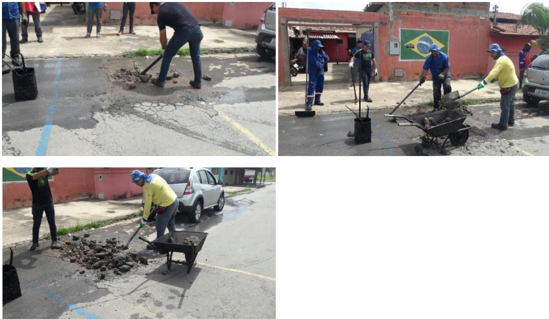
Figura 3. A – Quebrando o pavimento, B- Retirando o material e C- Colocando o material no carrinho.
