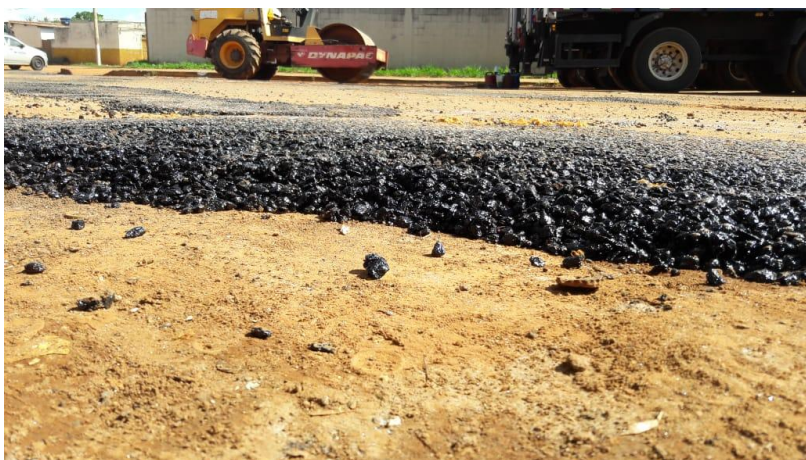
Figura 10. Camada final da massa asfáltica.
