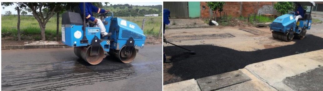
Figura 5. A, B, C, D – Aplicação da massa asfáltica E, F, G - Compactação. Fonte: Autoral.
