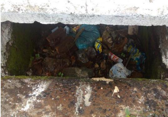
Figura 7. Boca de lobo obstruída.
