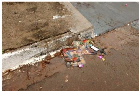
Figura 13. Sarjetas com obstrução do fluxo pluvial por vegetação crescida e resíduos carreados.
