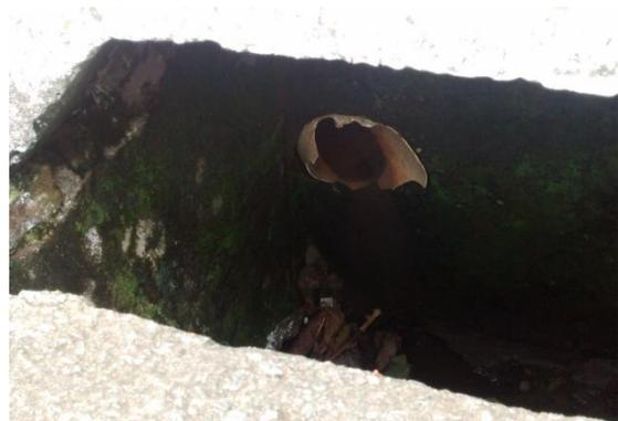
Figura 10. lançamento clandestina na rede de coleta de águas pluviais.
