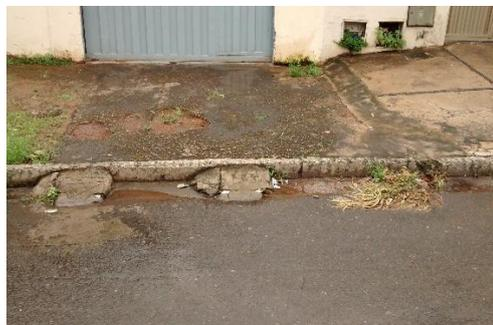
Figura 12. Sarjetas com obstrução por rampas de acesso à veículos.
