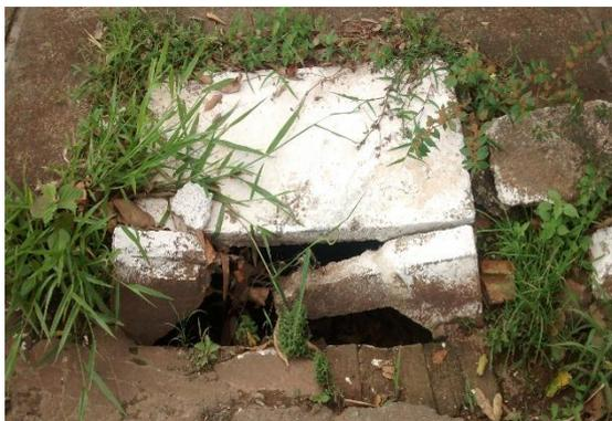
Figura 9. Boca de lobo com tampa e guia-chapéu quebradas.
