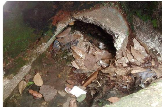
Figura 8. Boca de lobo com entrada da tubulação obstruída.
