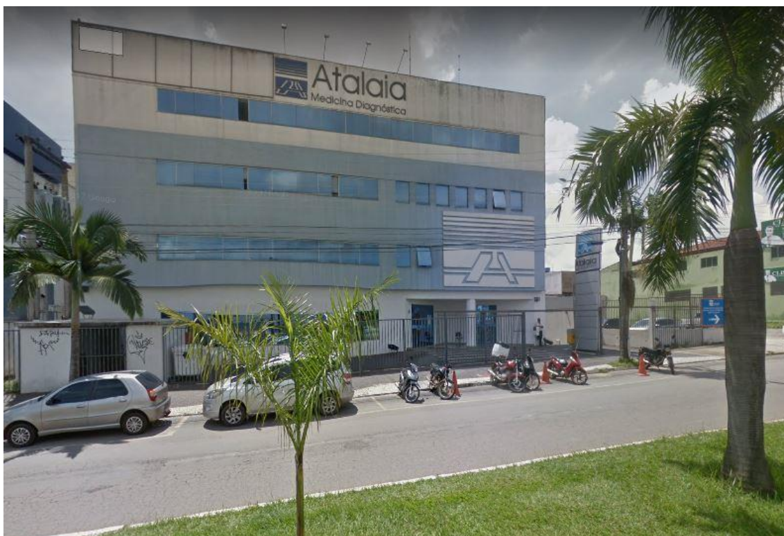
Figura 1. Fachada frontal do edifício modelo.
