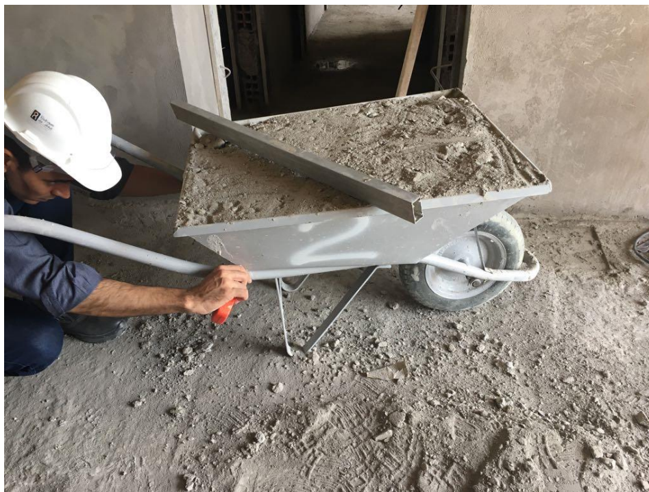
Figura 4 - Medição da perda de argamassa por apartamento. Fonte: Autores (2017)
