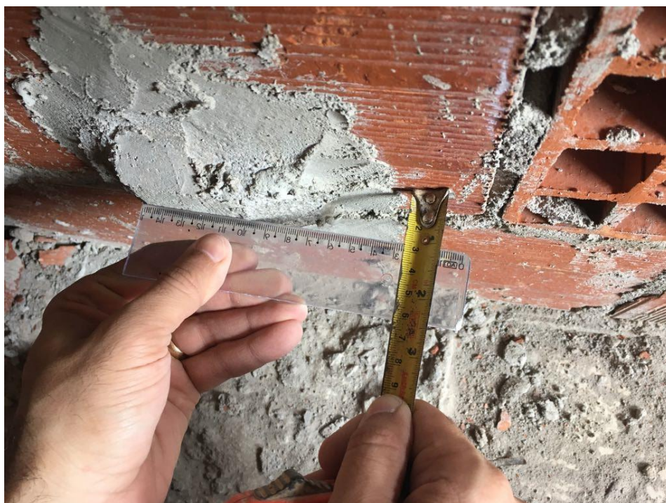
Figura 3 - Medição das taliscas por ambiente.
