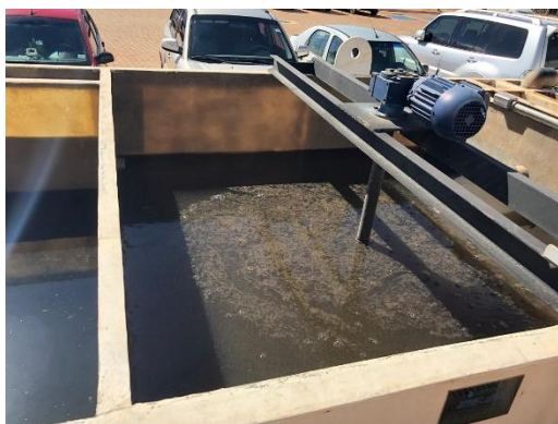
Figura 11: mistura rápida e floculação
