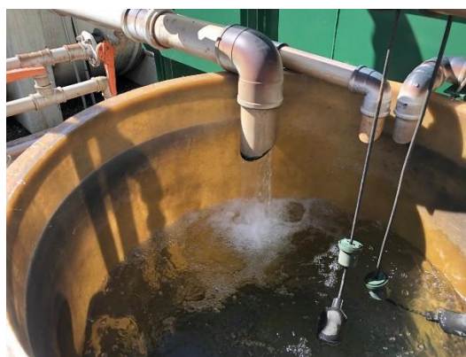
Figura 17: Separação água e óleo.
