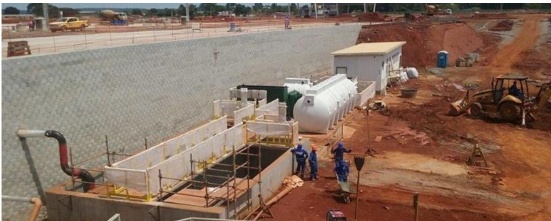
Figura 3: Aeroporto Internacional de Goiânia Tratamento de Águas Pluviais e Cinza para Reuso ( ETAPA DE EXECUÇÃO); Fonte : ECOBRASILIA (2016)
