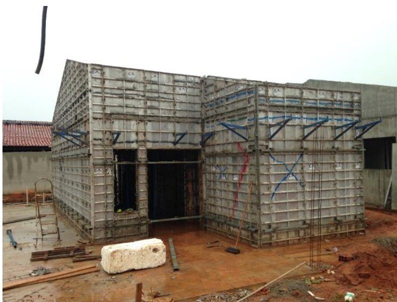
Figura 3: Fôrma Montada Fonte: Acervo Pessoal
