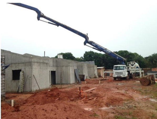
Figura 4: Lançamento do Concreto Fonte: Acervo Pessoal
