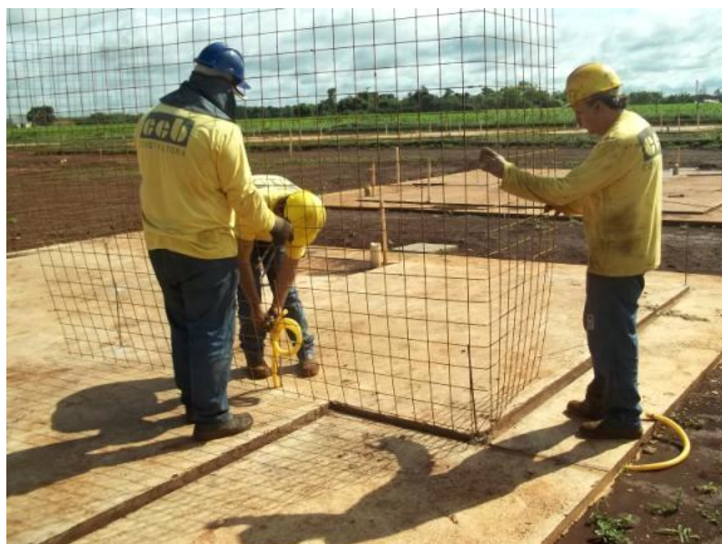
Figura 2: Montagem das Armaduras Fonte: Acervo Pessoal
