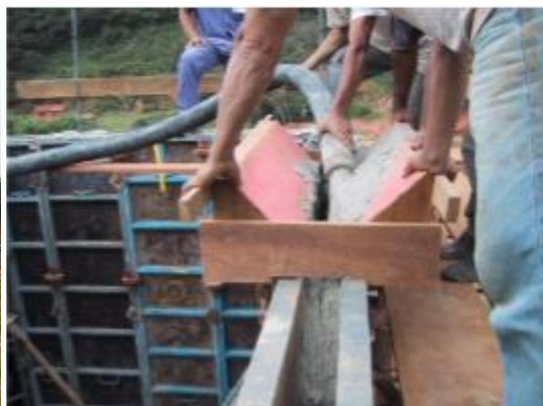
Figura 5: Concretagem das fôrmas Fonte: CÊSTA, 2009
