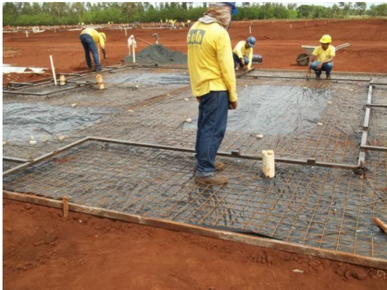
Figura 1: Execução da fundação em Radier Fonte: Acervo Pessoal
