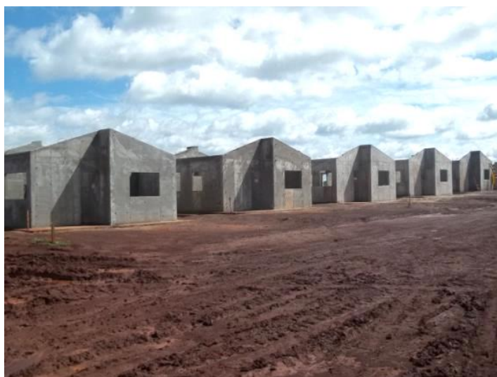
Figura 6: Casas pós desforma Fonte: Acervo Pessoal
