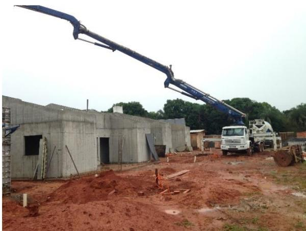
Figura 4: Lançamento do Concreto
