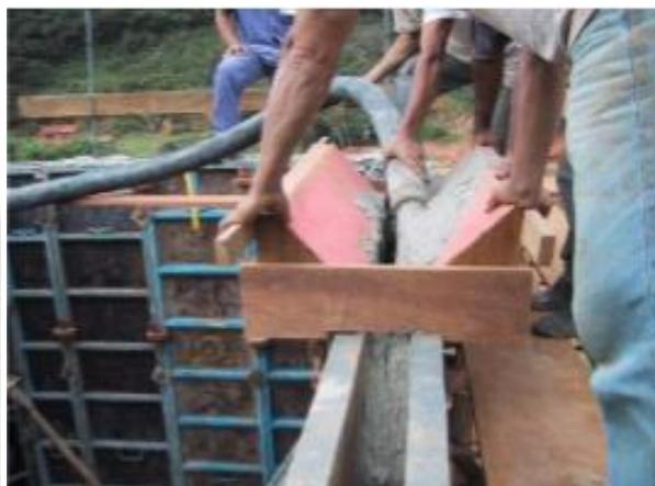
Figura 5: Concretagem das fôrmas
