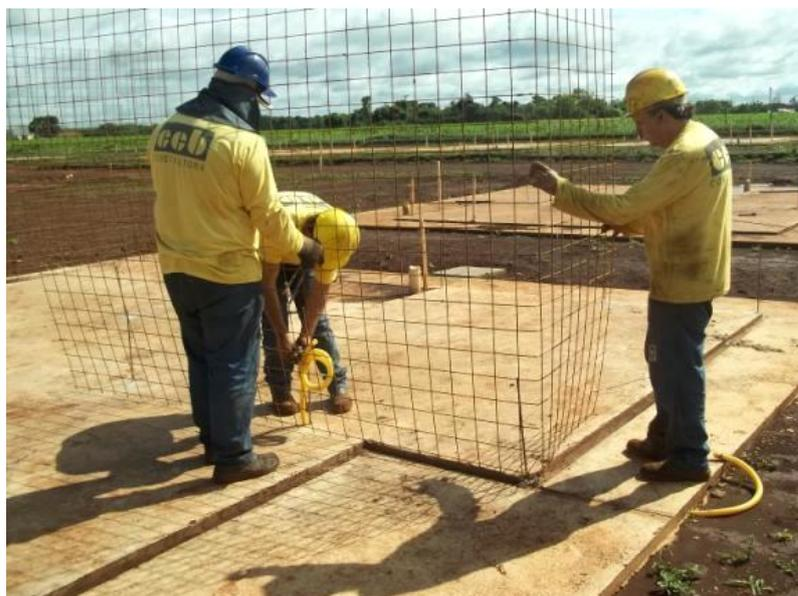
Figura 2: Montagem das Armaduras
