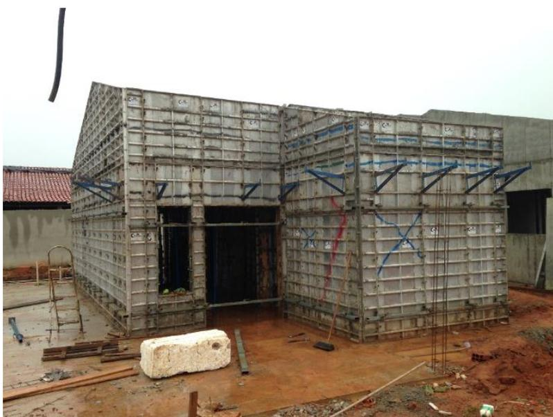
Figura 3: Fôrma Montada
