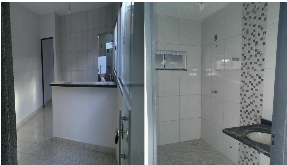
Figura 2 – Sala com cozinha americana e banheiro social. Casa no Setor Parque Solimões, Cidade de Goianira – GO
